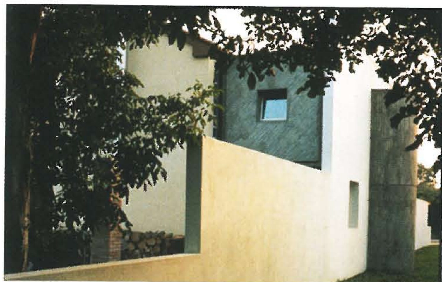
100 Ristrutturazione di una casa colonica Vazzola PierAntonio Val, Cecilia Ricci e Elvio Casagrande, 1981-1982 [foto GV]
