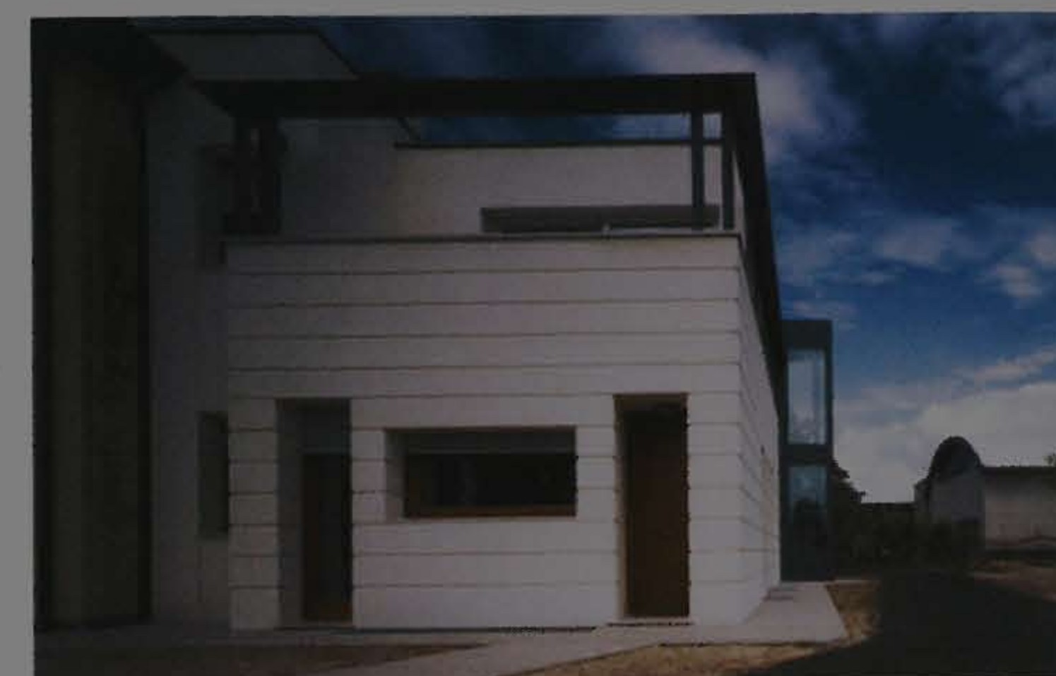
51 Casa Pin Battistella Via Vittorio Veneto, Fraz. Pianzano, Godega di Sant'Urbano Loris Dal Pos, 1999 [foto CA]
