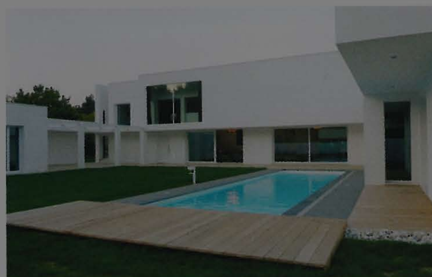
49 Villa Ferrarini Via degli Alpini 14, Cornuda Studio 101 Architetti Associati Malfitano-Selmin, 2008-2009 [foto SMS]
